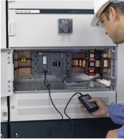
Festeinbau mit Leistungsschalter 3VA
