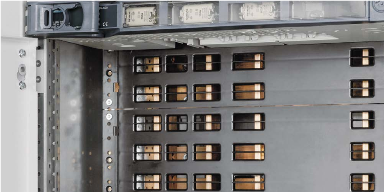
Steckschienensystem, prüffingersicher abgedeckt
