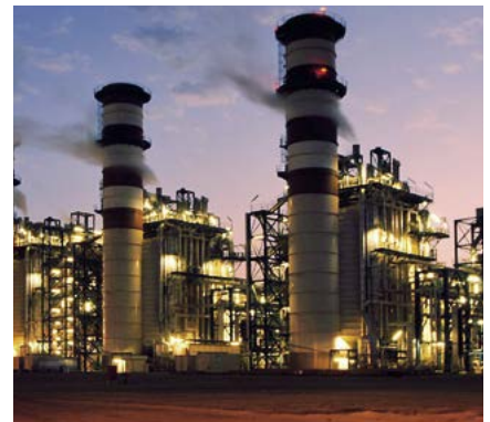
Sichere Energieversorgung auch bei hohen seismischen Anforderungen
